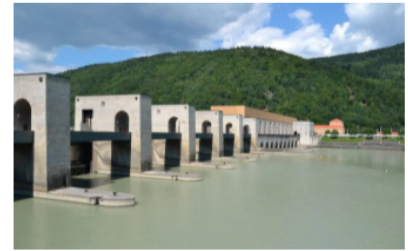
© Abb. 1 Kraftwerk Jochenstein
